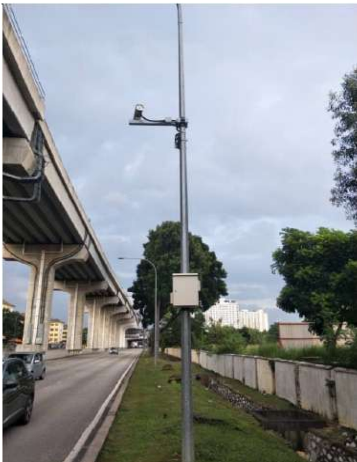
ITMS in Subang Jaya
