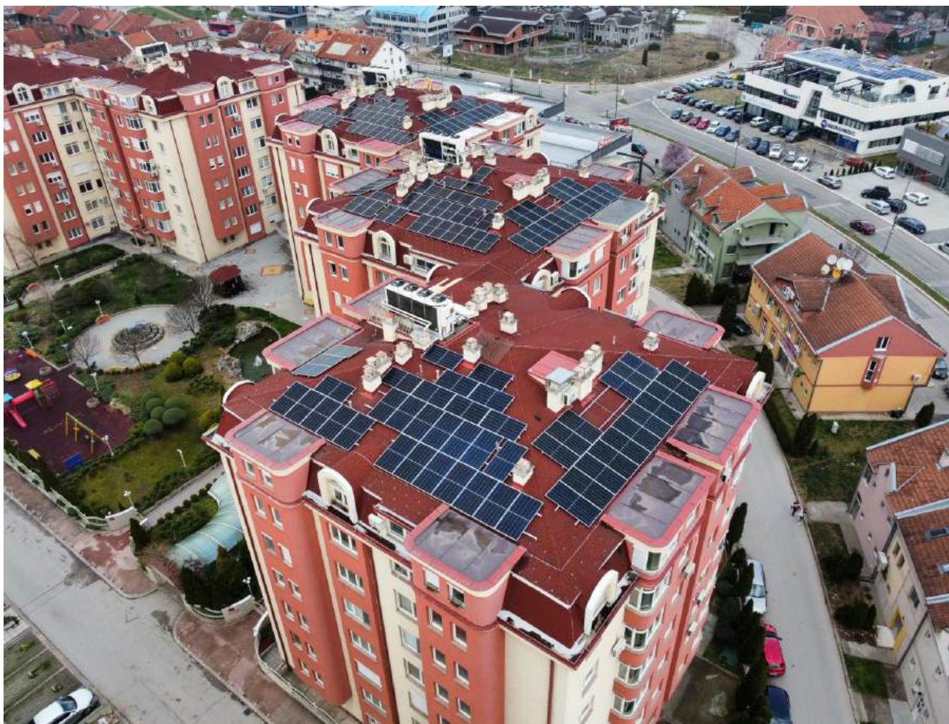
Слика 26. Стамбени комплекс МАГДОН Ниш са соларним панелима инсталираним на крову Извор: Енергетски менаџер Града Ниша, Centar za Održivi Razvoj Energetike – CORE d.o.o. Niš
