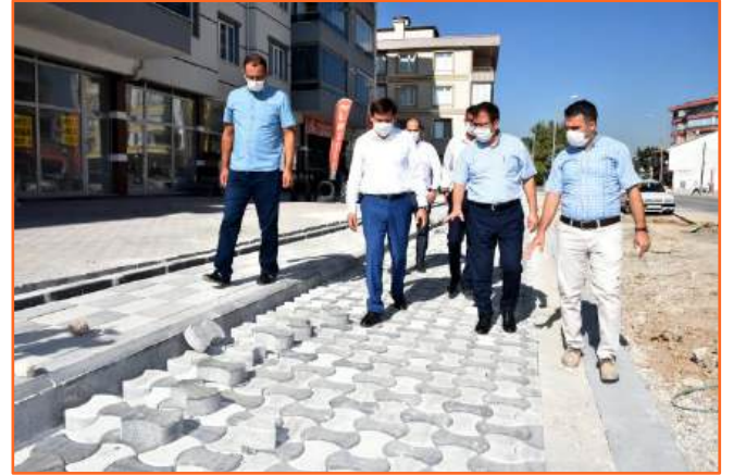
Fotoğraf 54: Bordür Çalışmaları
