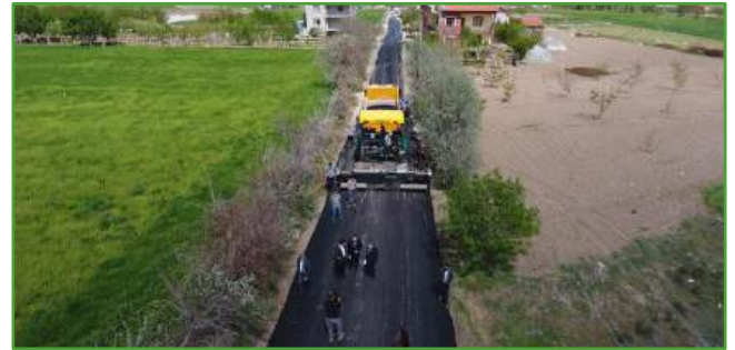
Fotoğraf 12: Karatay İlçesi Mahallelerinde Sathi Kaplama Çalışmaları
