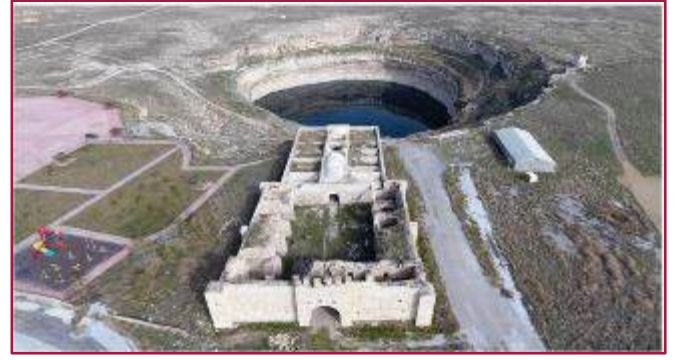
Fotoğraf 50: Obruk Han'ın Restorasyon Öncesi Görünümü
