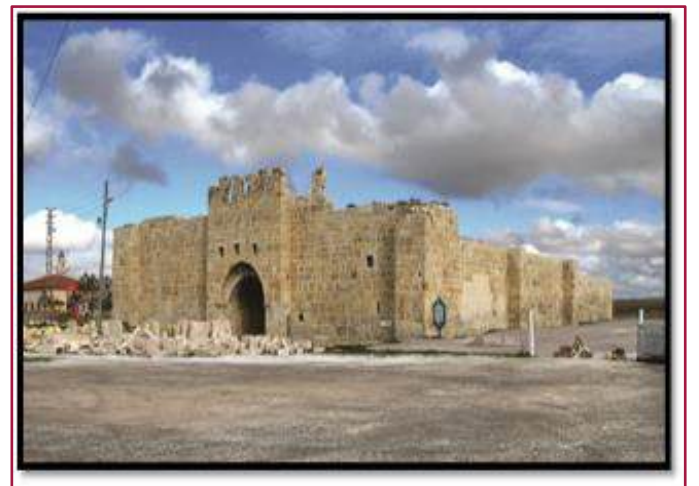
Fotoğraf 51: Obruk Han Restorasyon Çalışmaları
