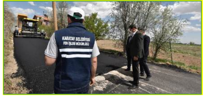
Fotoğraf 11: Karatay İlçe Merkezi Sokak Asfaltlama Çalışmaları
