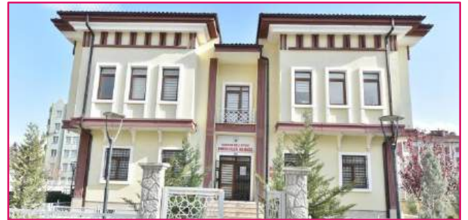
Fotoğraf 57: Karatay Belediyesi Emekli Konağı
