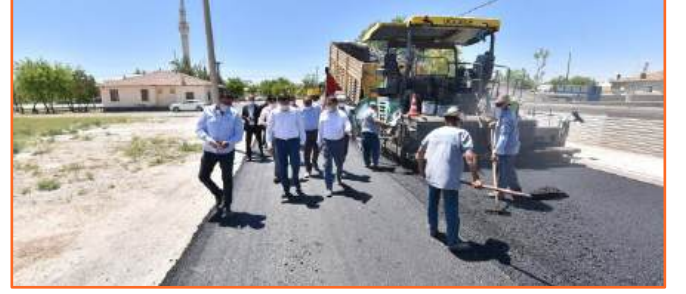
Fotoğraf 53: Asfalt Çalışmaları
