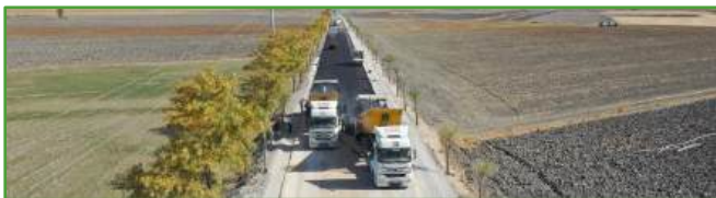
Fotoğraf 10: Merkeze Uzak Mahallelerde Sıcak Asfalt Çalışması
