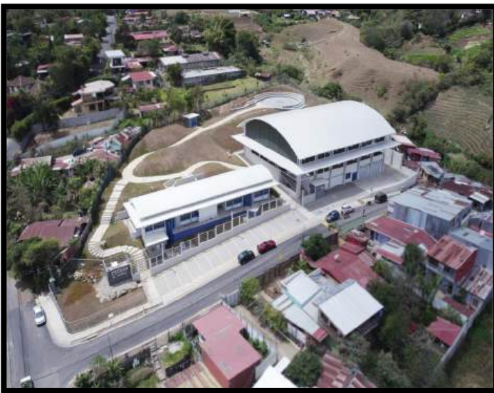
Construcción CECUDI Barrio El Carmen
