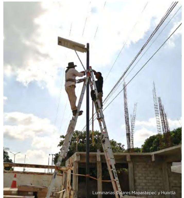
Instalación alumbrado público, Jiquipilas
