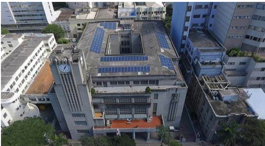
Figura 7.1 Vista aérea do Prédio Sede da PBH com Sistema FV sobre o telhado, 2020.
