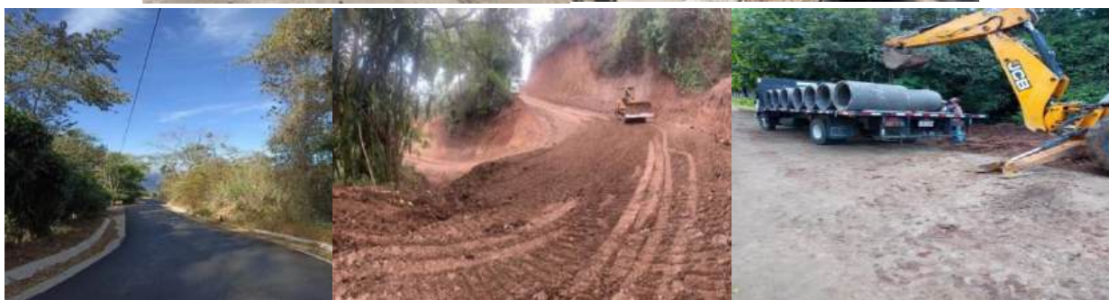
Imágenes: Mantenimiento y construcción de Carreteras y caminos cantonales.
