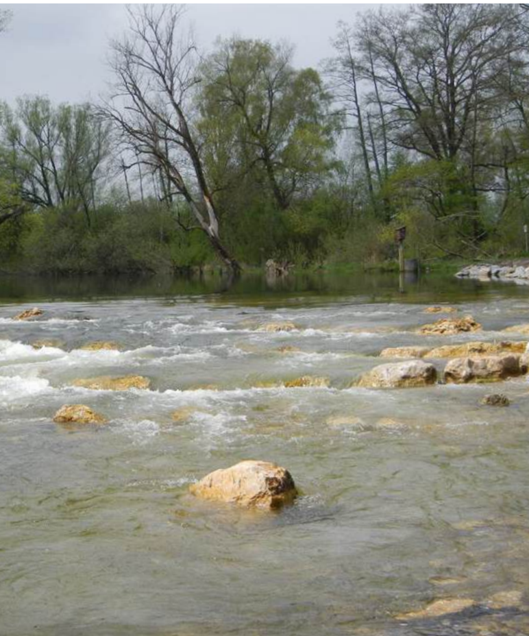
Abb. 6: Die 2013 gebaute Sohlrampe bei Grafrath erhöht den Wasserspiegel der Amper und trägt zur Wiedervernässung des Ampermooses bei.
